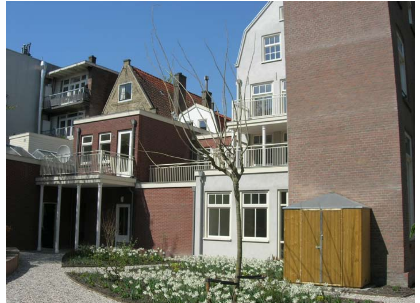
Nieuwe achtergevels Rozengracht 69, 71, 73 en 75
